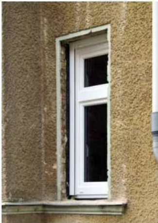
Bild 19: Straßenfassade Trelleborger Str.
