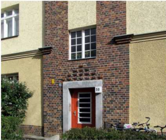
Bild 11: Straßenfassade Trelleborger Str. 50
