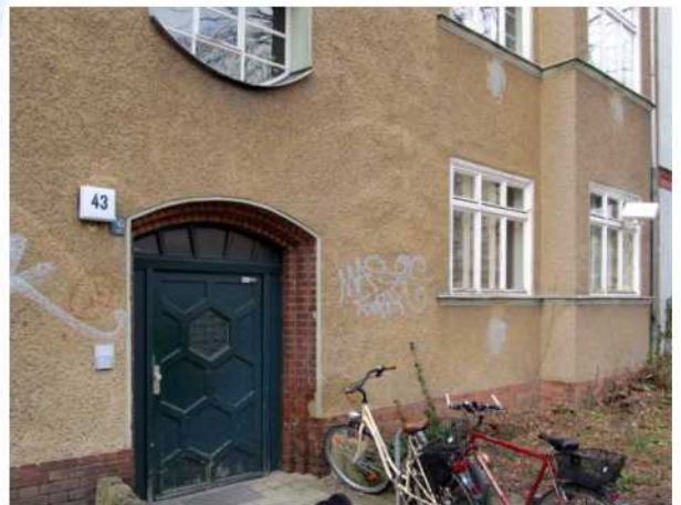
Bild 16: Straßenfassade Trelleborger Str. 43
