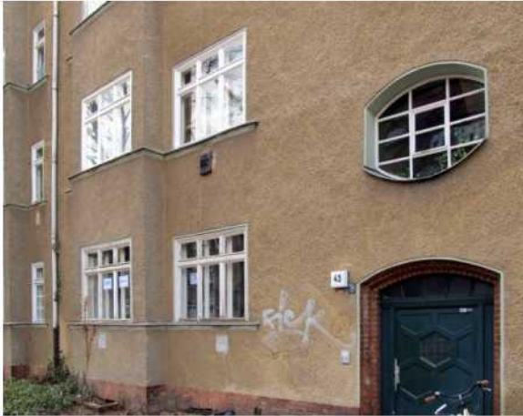
Bild 17: Straßenfassade Trelleborger Str.
