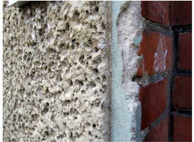
Bild 18: Straßenfassade Trelleborger Str.
