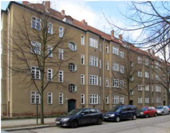
Bild 3: Straßenfassade Trelleborger Str. 39
