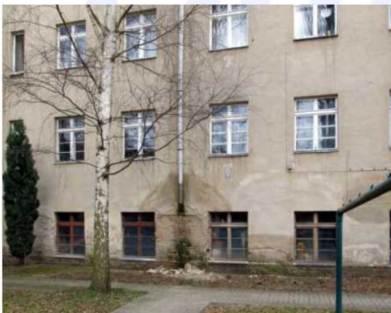
Bild 21: Hoffassade Trelleborger Str. 43/ 41
