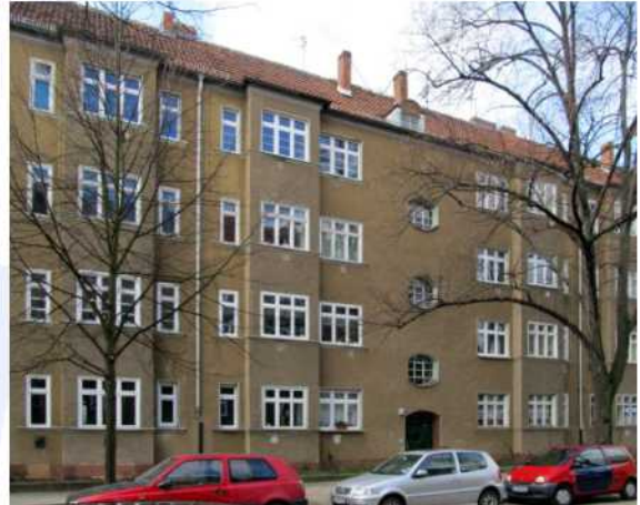
Bild 4: Straßenfassade Trelleborger Str. 41
