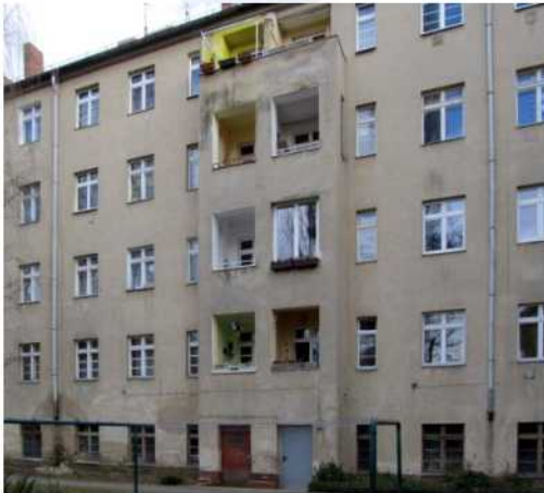
Bild 7: Hoffassade Trelleborger Str. 41
