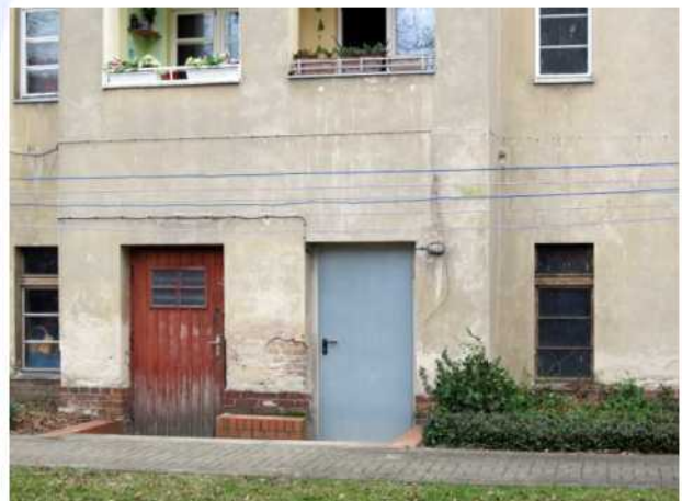
Bild 22: Hoffassade Trelleborger Str. 41
