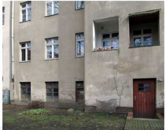
Bild 20: Hoffassade Trelleborger Str. 43
