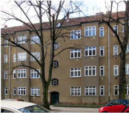
Bild 5: Straßenfassade Trelleborger Str. 41
