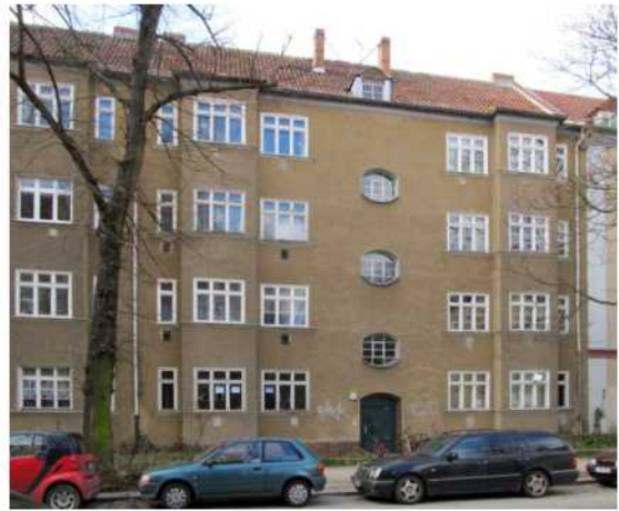
Bild 6: Straßenfassade Trelleborger Str. 43
