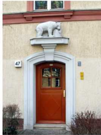
Bild 12: Straßenfassade Trelleborger Str. 47
