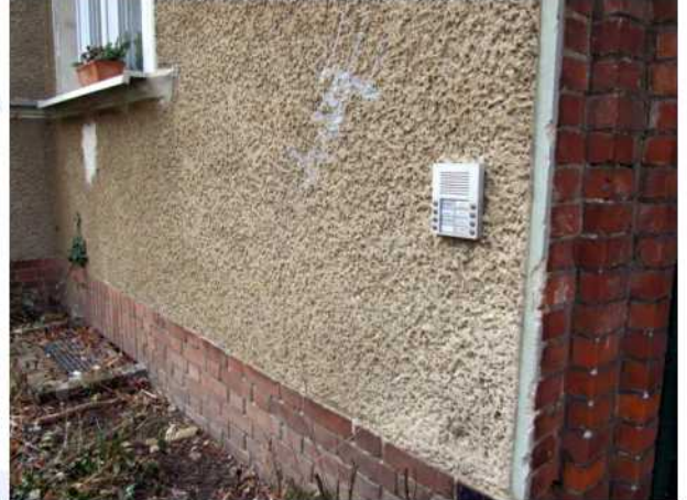
Bild 14: Straßenfassade Trelleborger Str.
